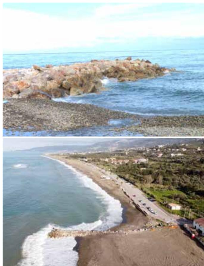
pennello in quel punto, sopraflutto alla strada lungomare, avrebbe bloccato il trasporto di sedimenti determinando un accumulo ad ovest ma innescando l'erosione ad est dov'era stata costruita la strada. Come è stato possibile costruire una strada sull'arenile aggirando una legge regionale (la n.78 del 1976) che la vieta?
