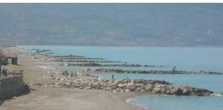
Essi riproducendo l'effetto-trappola dei sedimenti trasportati lungo costa, hanno moltiplicato i punti sottoposti ad erosione, aggravando ulteriormente il dissesto delle nostre spiagge. Dopo ogni intervento sottoflutto si manifestava il processo erosivo, tanto vistoso quanto evidente era l'effetto di intrappolamento della sabbia fra le difese eseguite. L'intervento nella zona così dissestata seguiva a breve termine, rinnovando il dissesto più a levante.
